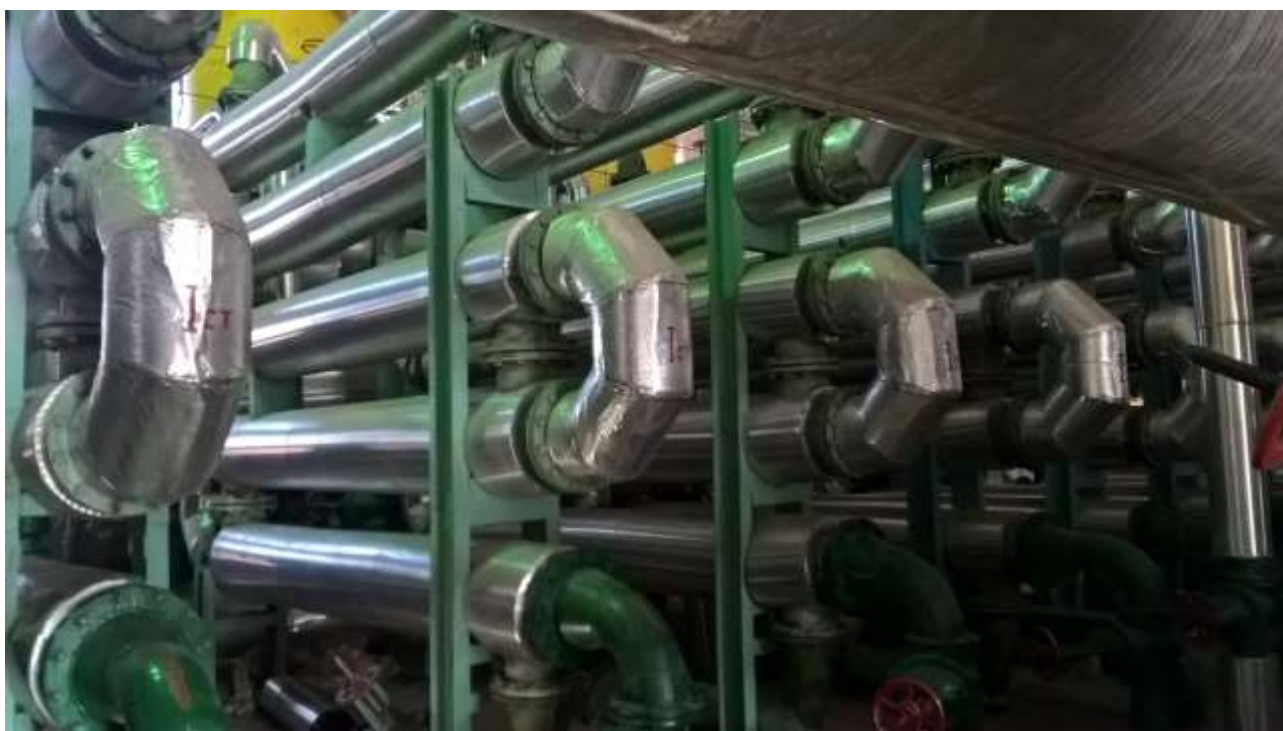
Рис.2. Аппараты, вместо одной секции которых был установлен два аппарата ТТАИ
