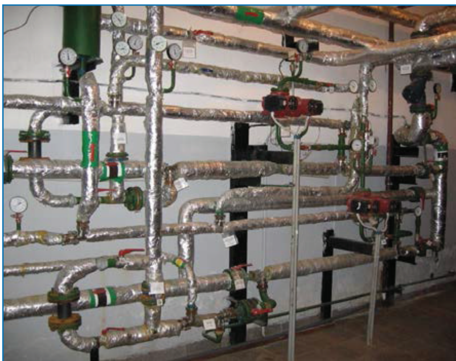
Рис. 1. ИТП разместился в плоскости стены.
